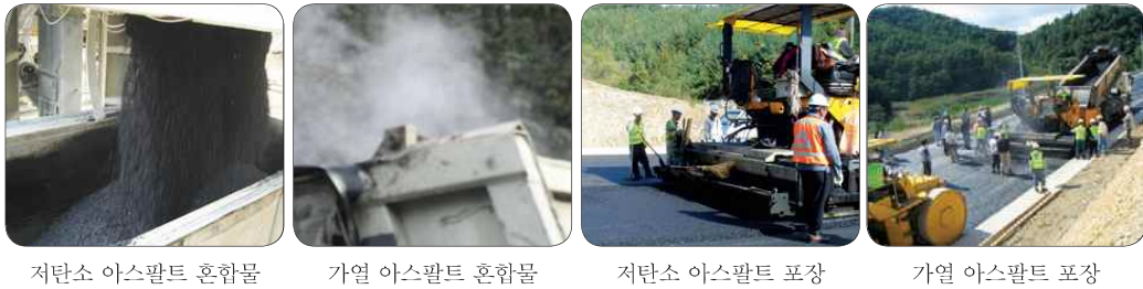
〈그림 1〉 저탄소 아스팔트 포장의 시공 중 유해연무 발생 비교 모습
