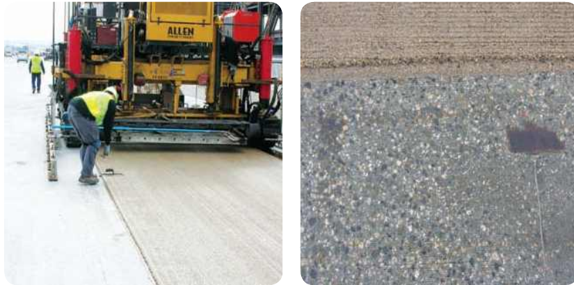
〈그림 1〉 캘리포니아주 Bay Bridge에 두께 2cm의 박층 폴리머 콘크리트를 포장하는 광경
